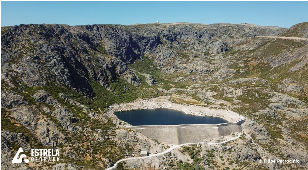
Figura 5. Vista do Covão do Ferro e respetiva barragem.
