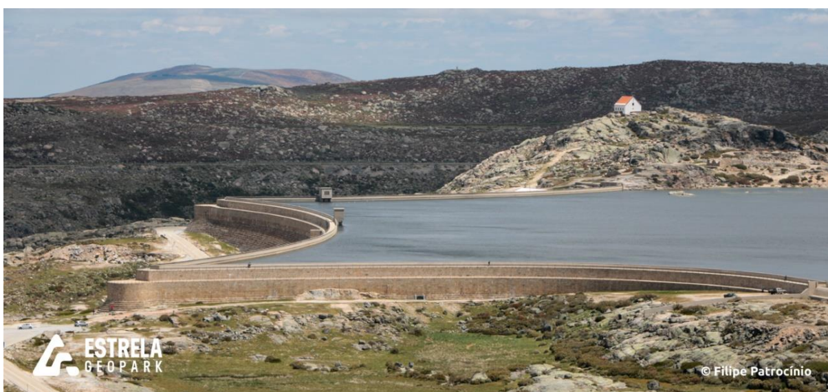
Figura 7. Vista do Paredão da Barragem da Lagoa Comprida.
